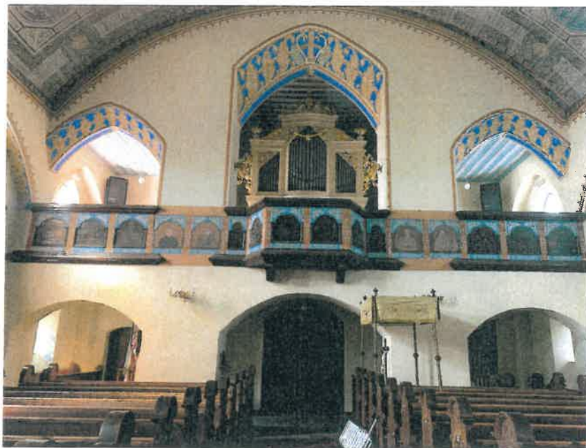
Fot. 1 Empora chórowa przed konserwacją
