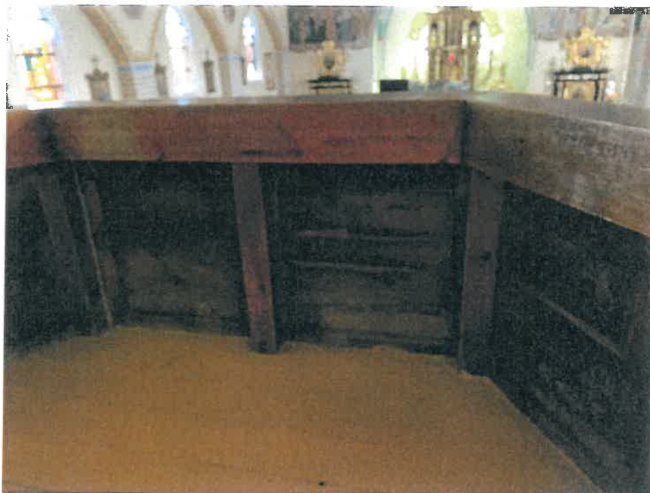
Fot. 9 Konstrukcja empyry od strony ściany zachodniej
