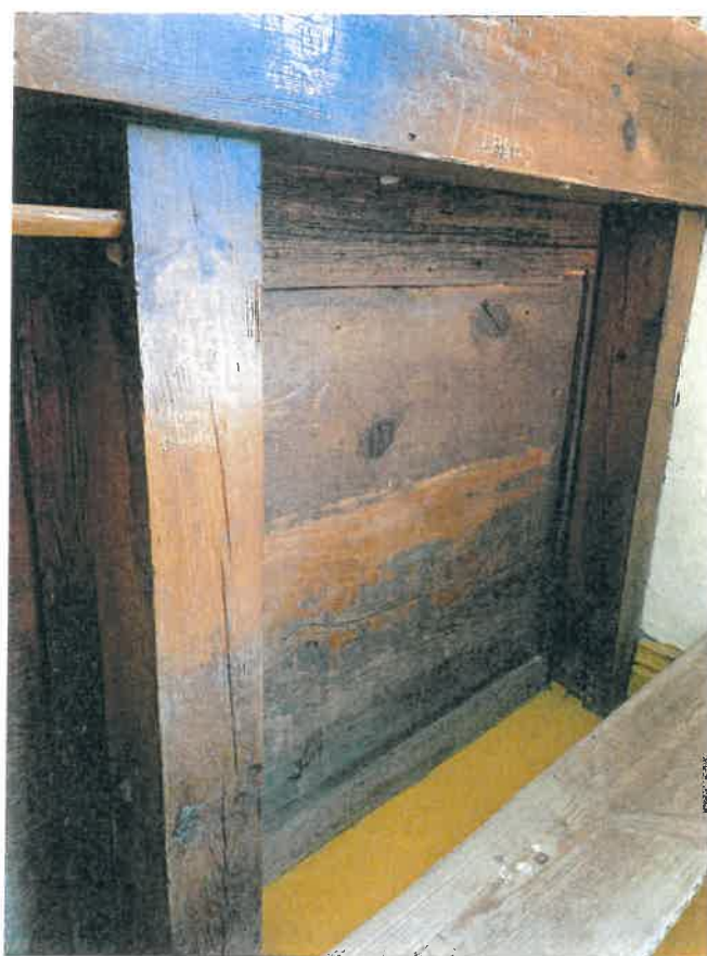
Fot. 10 Konstrukcja empyry od strony ściany zachodniej, gruba warstwa wtórnego lakieru
