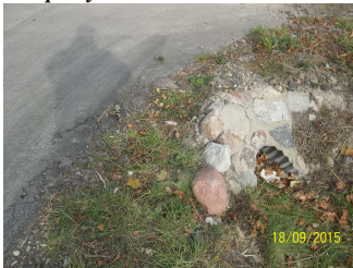
Przepusty - luźne kamienie zabruku do ponownego montażu
