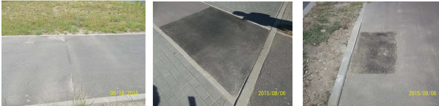
Kratki ściekowe , pokrywy włazów zaniżenie lub zawyżenie względem nawierzchni o 0,5 cm do regulacji
