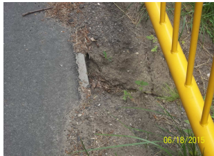
Przepusty - luźne kamienie zabruku do ponownego montażu
