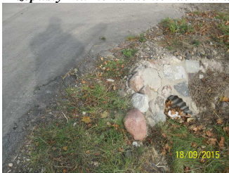
Przepusty - luźne kamienie zabruku do ponownego montażu
