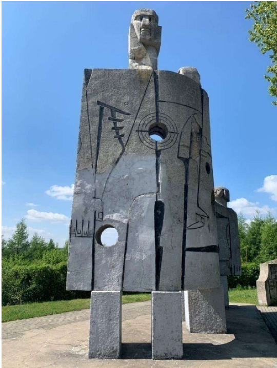
Fot.3 Stan zachowania pomnika. Widoczne wtórne uzupełnienie dużego ubytku warstwy zewnętrznej oraz powłoka malarska.
