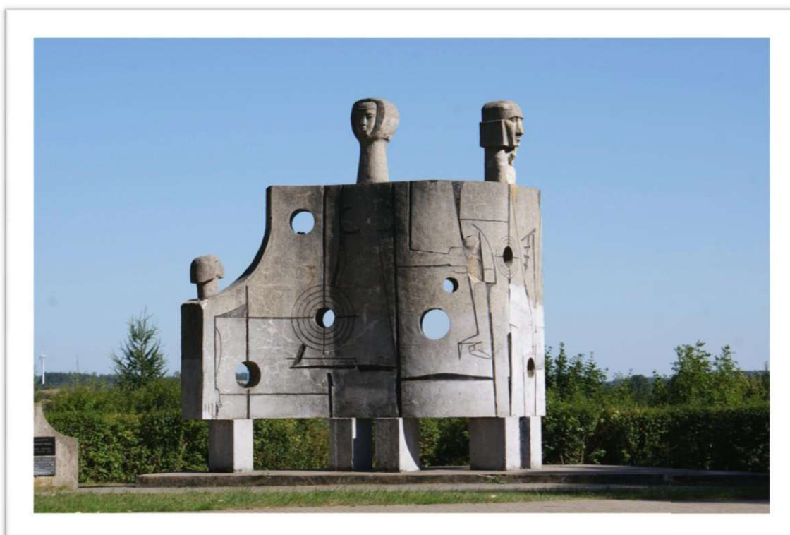
Fot. 17 Ogólny stan zachowania pomnika od strony południowo-zachodniej.
