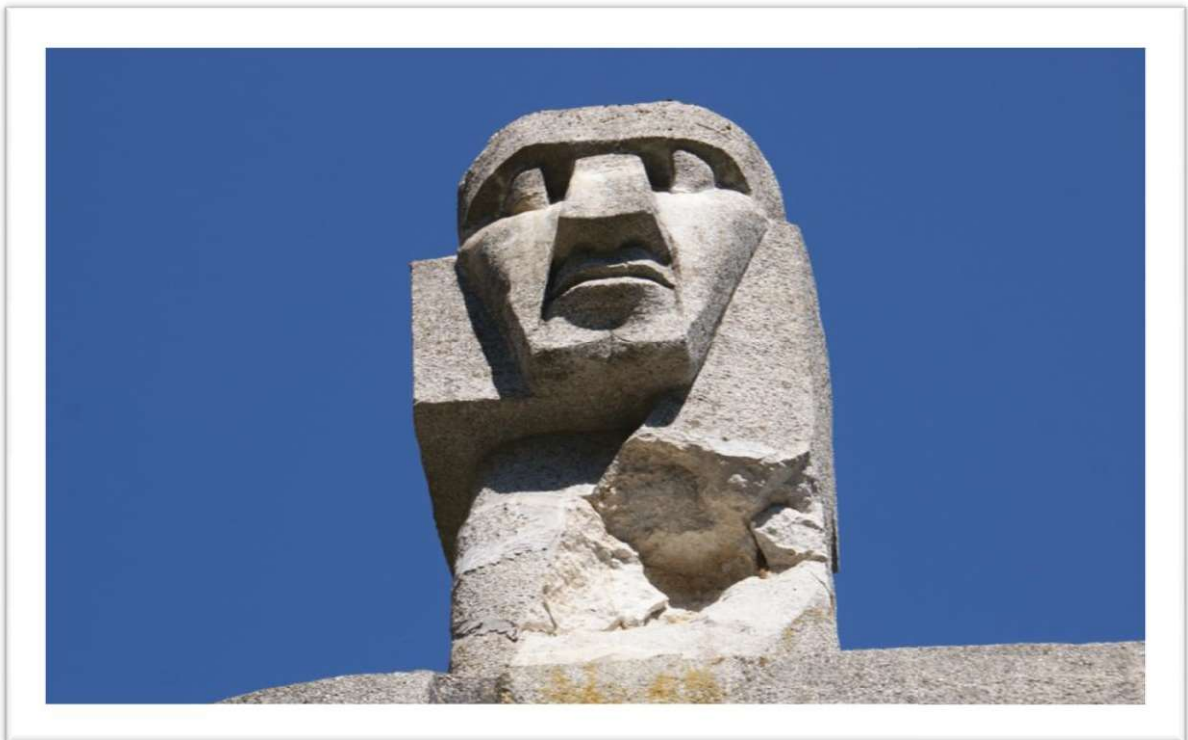
Fot.12 Duży ubytek głowy postaci męskiej.
