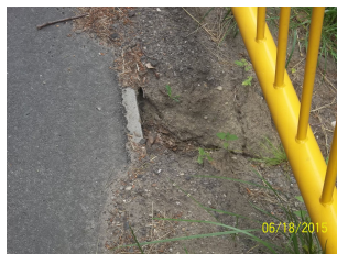
Przepusty - luźne kamienie zabruku do ponownego montażu
