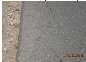
uszkodzona/speknięcia krawędź
